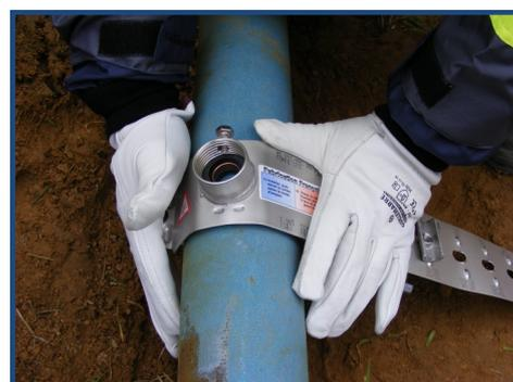
Poser le collier côté joint sur la canalisation et appuyer de chaque côté pour le préformer
