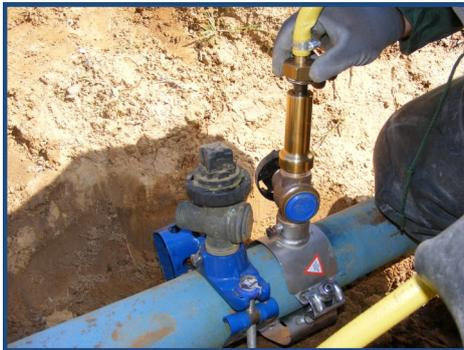
Retirer le raccord incorporé du robinet, insérer la pige de centrage et la visser
