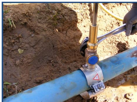
Fermer le robinet, contrôler l'étanchéité de l'ensemble
