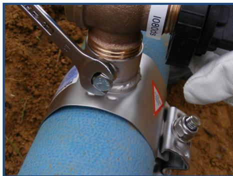
Orienter le robinet en le vissant jusqu'à obtenir l'étanchéité : mini 0.5 tour, maxi 2 tours en fonction de l'état de la canalisation. Serrer la vis de blocage en butée avec une clé de 13
