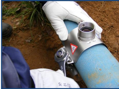
Serrer l'écrou Nylstop ou laiton sécable (sans le bloquer ni le rompre) avec une clé de 19 jusqu'à ce que le collier commence à ne plus bouger.
