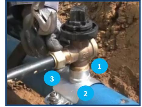
Vérifier visuellement l'étanchéité des différents points de jonction :
